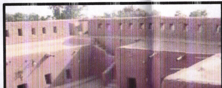
Les murs claustrés maçonnerie en forme géométrique assemblant des losanges entre coupés horizontalement
