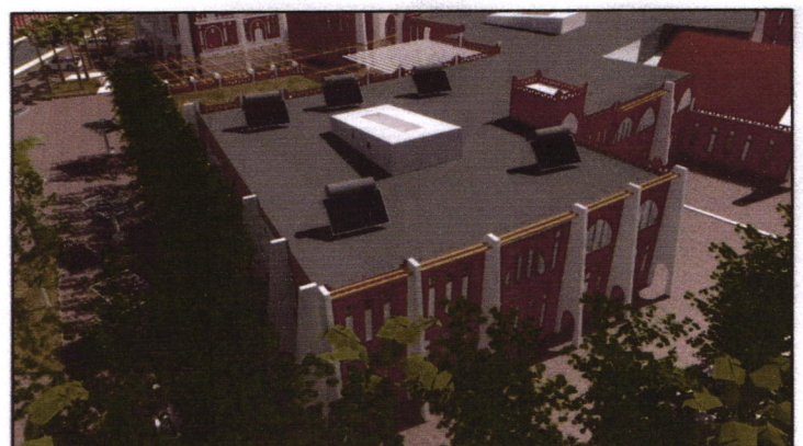
Figure 83 Emplacement des capteurs CES dans la terrasse de l'école (Source: auteur)
