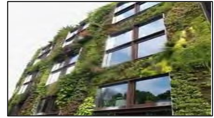
Figure I-16: Mur végétal du musée Quai Branly réalisé par Patrick Blanc (Source : www.murvegetalpatrickblanc.com )
