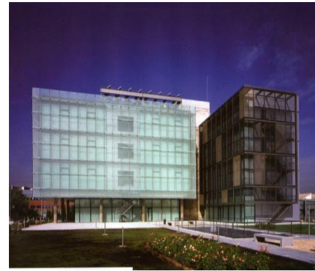
Figure I-79 : la façade vitrée
