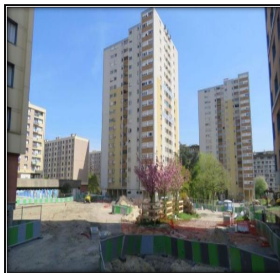
Figure 2.23 Photo :Cité La Noue en chantier
