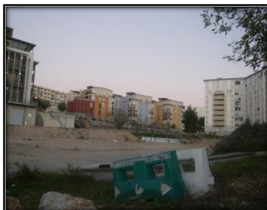
Figure 2.17 Photo : Terrain nu après démolition du bâtiment tripode
