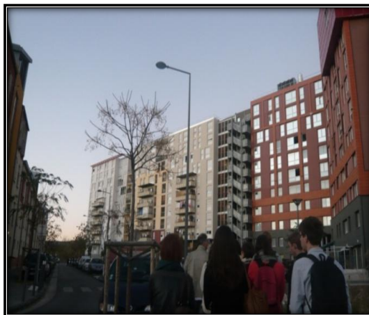
Figure 2.19 Photo des façades réhabilitées de la cité
