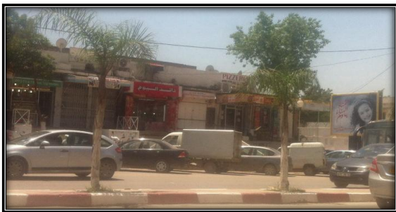
Figure 3.36 Photo du marché( à démolir )
