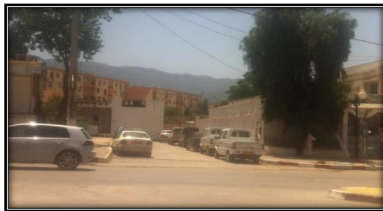
Figure 3.37 Photo d'un ancien accès à la cité fermé
