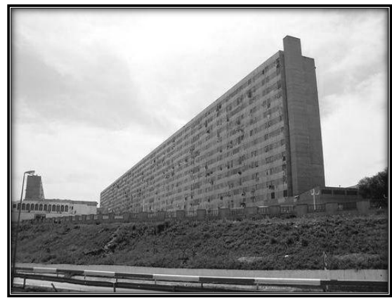
Figure 2.5 Photo de l'immeuble des Dunes
