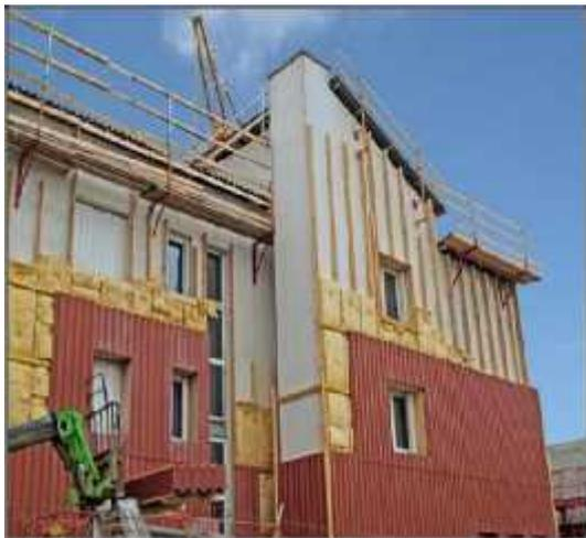
Figure: Isolation renforcé de l'extérieur
