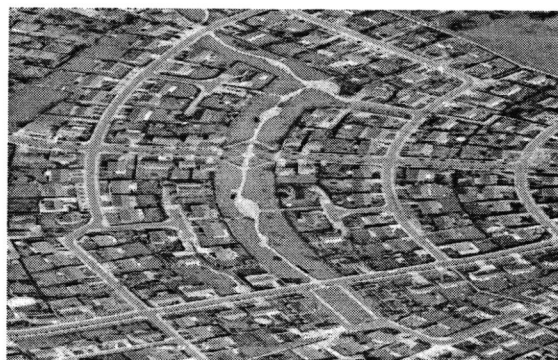
Figure 15 lotissement d'habitation individuelle
