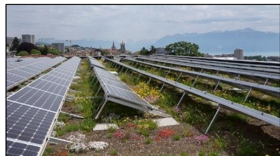
Figure 119 (3.1.3.2) : Combinaison toiture végétalisée et panneaux solaires. Source: Consultée le 10/09/2017 à l'adresse : http://www.lausanne.ch/en/thematiques/nature-parcs-et-domaines/politique-ecologique/toitures-vegetalisees/vegetation-et-panneaux-solaires.html
