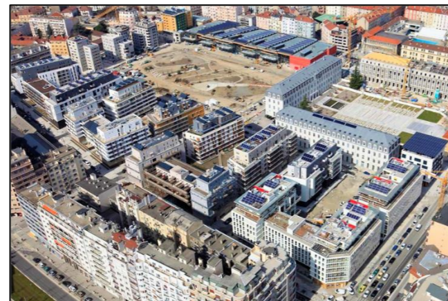
Figure 27 (3.3.5.1) : Panneaux solaires thermiques des logements. Source: Grenoble : ville durable. La ZAC de Bonne, un ÉcoQuartier en centre-ville , 2010, p. 10.
