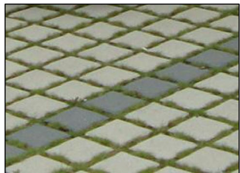
Figure 123 (3.1.4.2) : Pavé de béton drainant. Source: Consultée le 10/09/2017 à l'adresse : http://www.pierreetsol.com/Pages/Vente/pave%20drainant.htm
