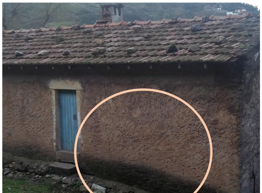
Figure 58: Vue sur les enduits extérieurs de la maison (Source : prise sur site).
