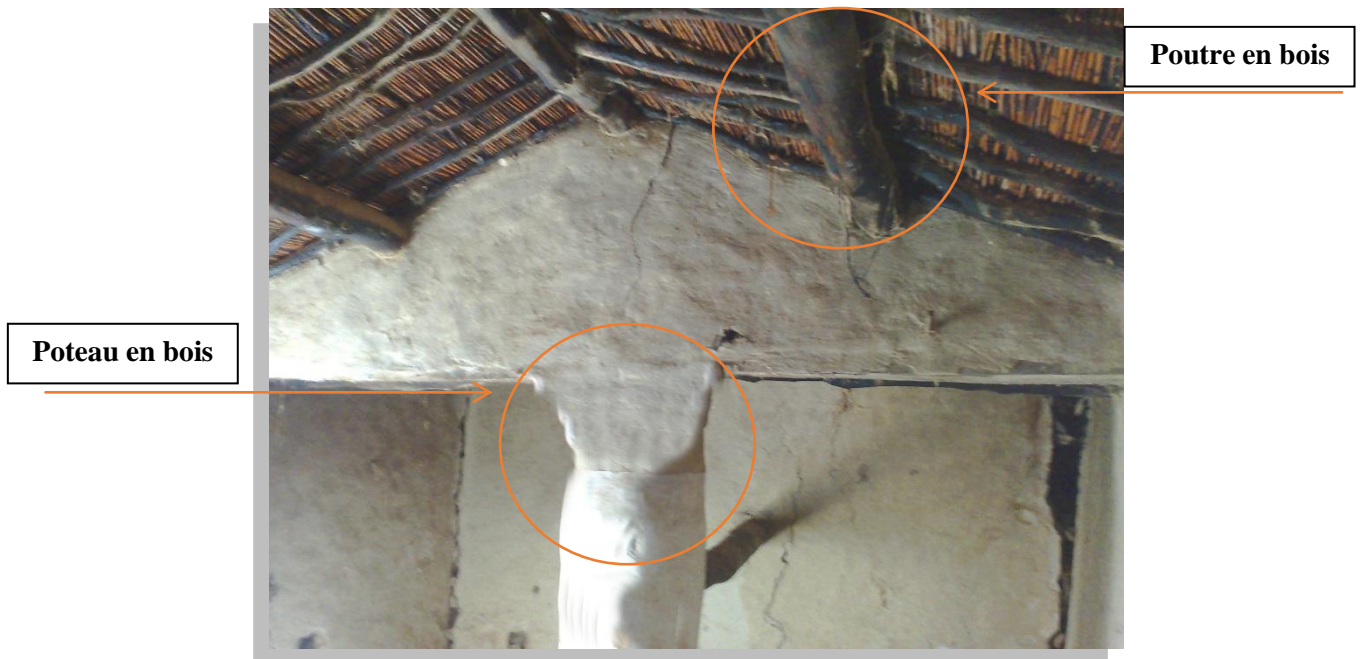
Figure 55 : Vue sur la structure de la maison (source : auteur)
