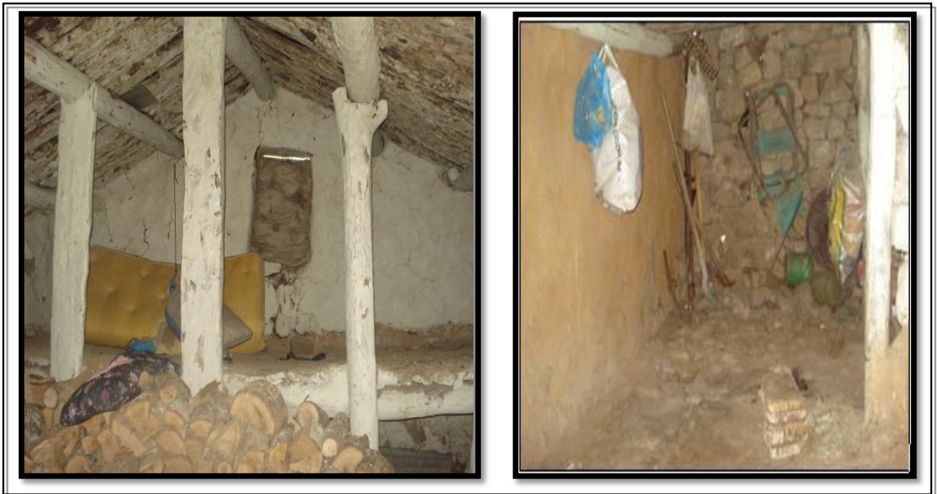
Figure 37 : A gauche, vue sur Taâricht, à droite, vue sur Addaynine, (Source : ALILI Sonia, Thèse magister en architecture, « guide technique pour une opération de réhabilitation du patrimoine architecturale villageois de Kabylie » (université tizi-ouzou).
