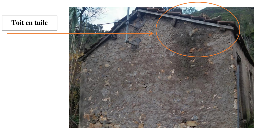
Figure 56 : Vue sur le toit de la maison (Source : prise sur site)
