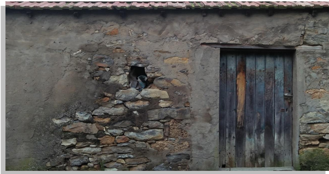
Figure 51 : Vue sur le mur de la maison (source auteur)
