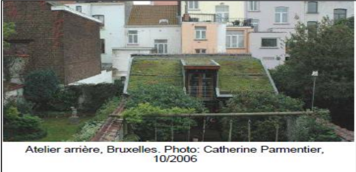
Figure 08 : exemple de toit végétalisé à Bruxelles (source : réaliser des toiture vert) livre delivrè par institut bruxellois pour la gestion de l'envirennement ).
