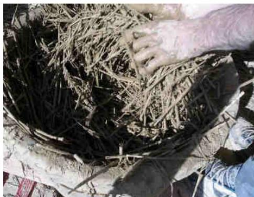
Figure 07 : mélange de paille et de terre pour la constitution de murs, (source : passeurs d'Energie asbl(02))
