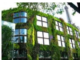
Figure 20 : façade végétalisée en intégrant la flore au bâtiment via des balconnières. Source : la végétalisation des bâtiments PDF en ligne
