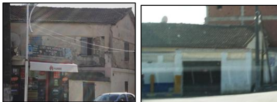
Figure II.8 : le batis existant depuis l'indépendance Source : auteur
