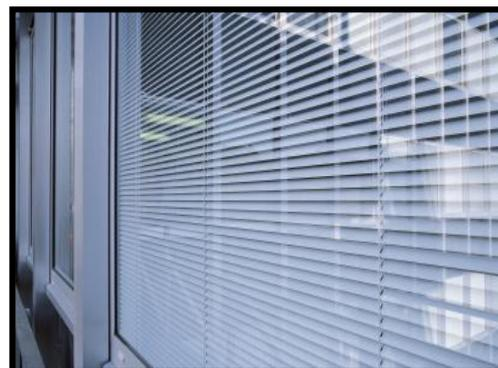
**Figure 98 :** store intégré. Source : <http://glassolutions.sk/fr/produits/double-vitrage-avec-stores-integres>
