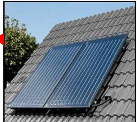
Figure 120 : Panneau thermique Source : <https://www.batirama.com/article/7217-solaire-thermique-et-photovoltaique-les-solutions.html>
