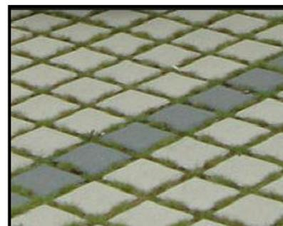
**Figure 113 :** pave en béton poreux.
