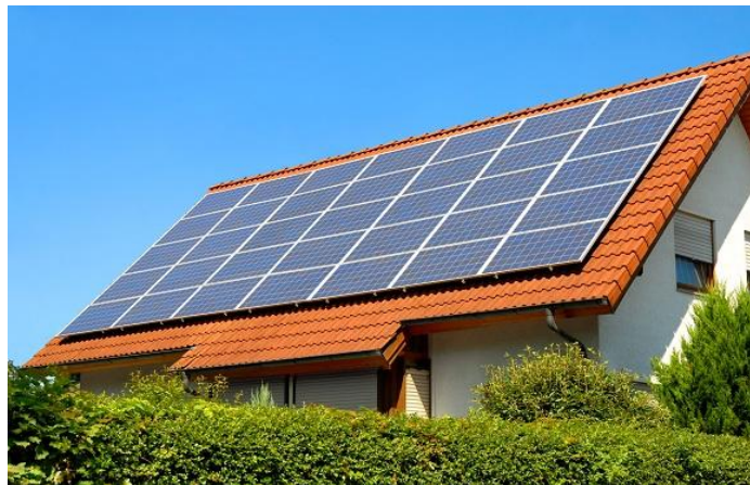
Figure 24 panneaux photovoltaïques source (confort et privilège de France, 2017)
