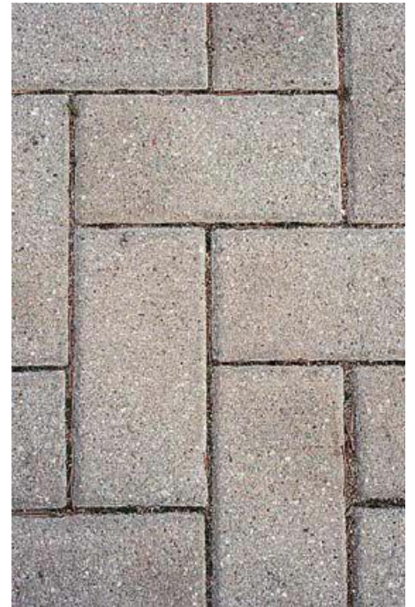
Figure 28 dalle imperméable avec des joints perméables source (mansouri, 2008).
