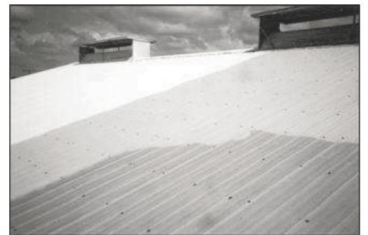
Figure 30 Enduit réfléchissant appliqué sur un toit source (Deny & Gaumont, 2008)
