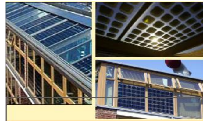
Figure 15 : Panneaux solaire, toiture et façade Source : http://ecoquartier.ch/wp-content/uploads/2016/05/BedZED
