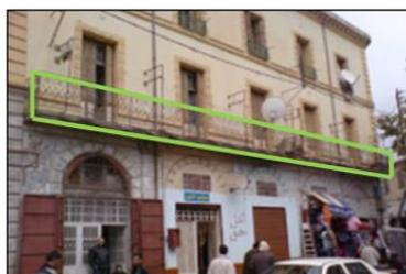
Figure 3.53: Balcon en fer forge.
