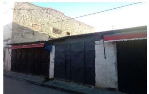
Figure 32: photo de l'état actuel de terrain d'intervention
