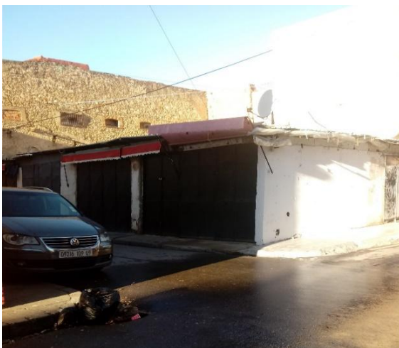
Figure 31: photo de l'état actuel de terrain d'intervention
