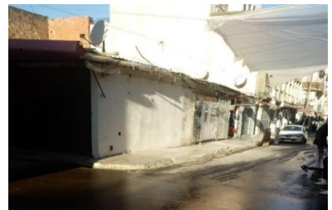
Figure 30: photo de l'état actuel de terrain d'intervention
