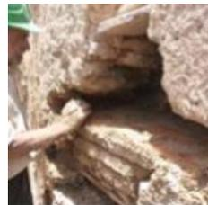
Figure 87: Remplir le creux avec de la brique
