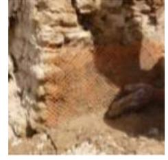
Figure 83: Enduit en terre, renforcé d'un treillis en PVC
