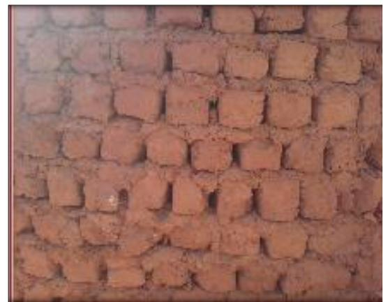
Figure 52: La face d'un mur porteur. Source : auteur
