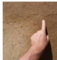
Figure 103: Des fissures après le séchage source : [www.craterre.org](http://www.craterre.org)
