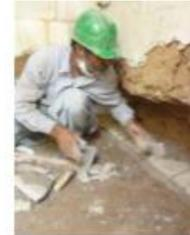
Figure 93: Barrière anticapillaire à l'aide de briques
