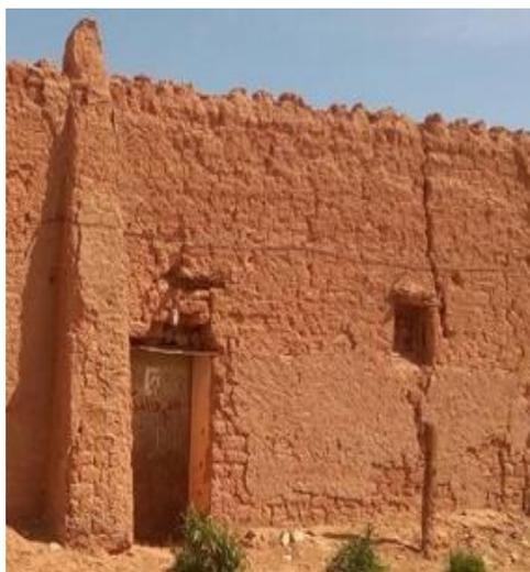
Figure 67: Fissures des murs porteurs dans des directions différentes source : auteur
