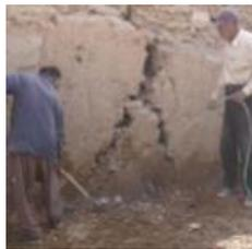
Figure 85: Arrosage de la fissure
