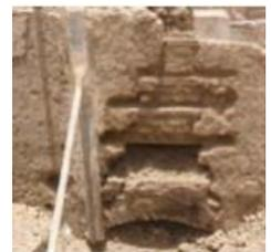
Figure 88:Procéder lentement et ménager des temps de séchage
