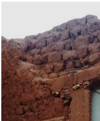
Figure 63: Déchaussement des briques source : auteur
