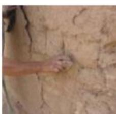
Figure 108:Racler la surface et les joints de mortier source : [www.craterre.org](http://www.craterre.org)
