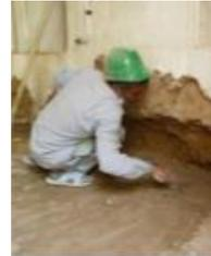
Figure 92: Couler le Mortier de terre
