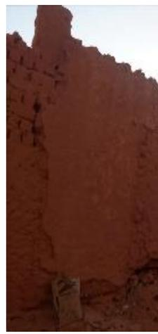
Figure 65: Détériorations des bases des murs
