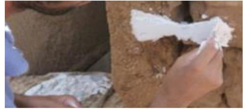
Figure 78:Application du plâtre
