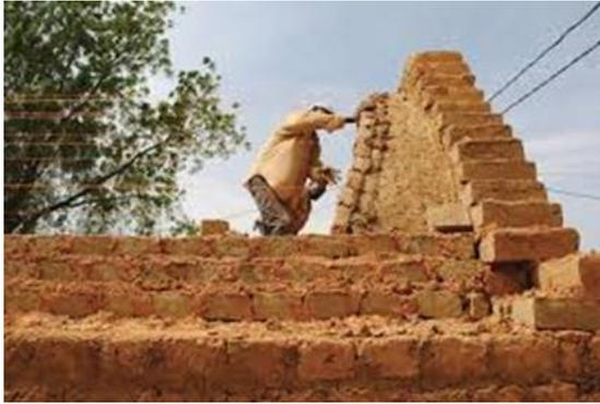
Figure 36: Construction de la voute nubienne Source : <http://ecoledecoutureniger.wixsite.com/terree>
