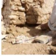
Figure 81: Remplir la du mortier
