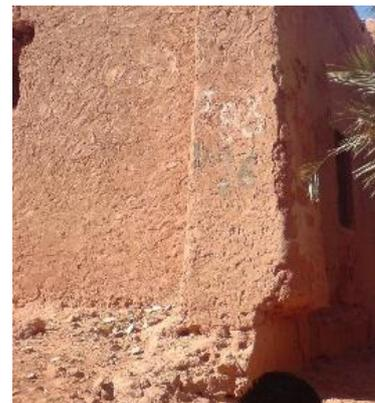
Figure 72: Détérioration de la base
