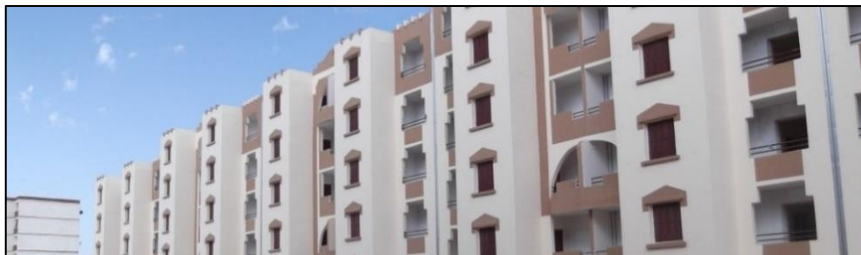
Fig. 6 Logements sociaux Tizi Ouzou Source : Site https://www.algeriepatriotique.com/
