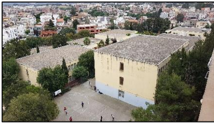
Fig. 133 Lycée Saad Dahleb Source : Prise par l'auteur.
