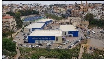
Fig. 119 Hangar commerciaux Source : Prise par l'auteur.
