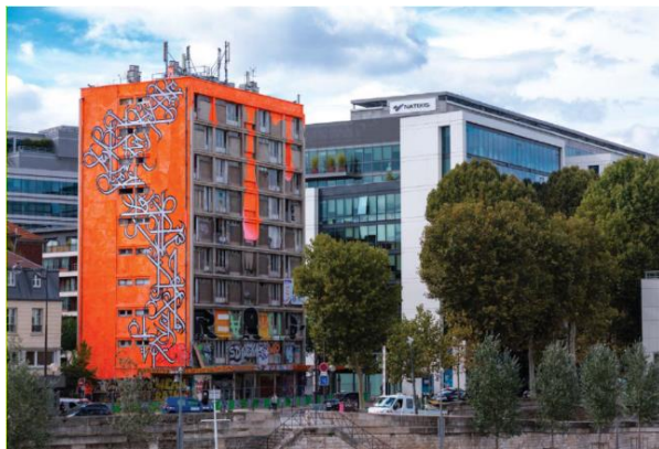
Fig. 35 Tour Paris 13 (avant démolition)
