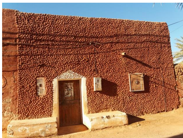
Figure 5: la façade de dar el djemaa à Timimoun (2018). Source : les auteurs
