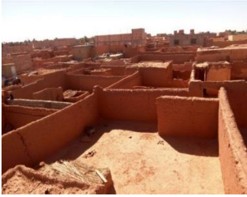
Figure 6 : la terrasse de la maison Khemira à Timimoun (2018). /Source : les auteurs
