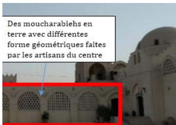
Figure 52: la façade nord du centre Source : google maps
