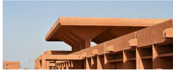
Figure 19: Vue sur toiture isolées Source : www.archdaily.com
