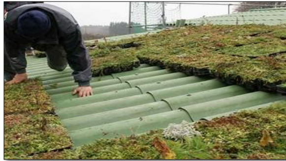
Fig. les toitures vertes extensive
