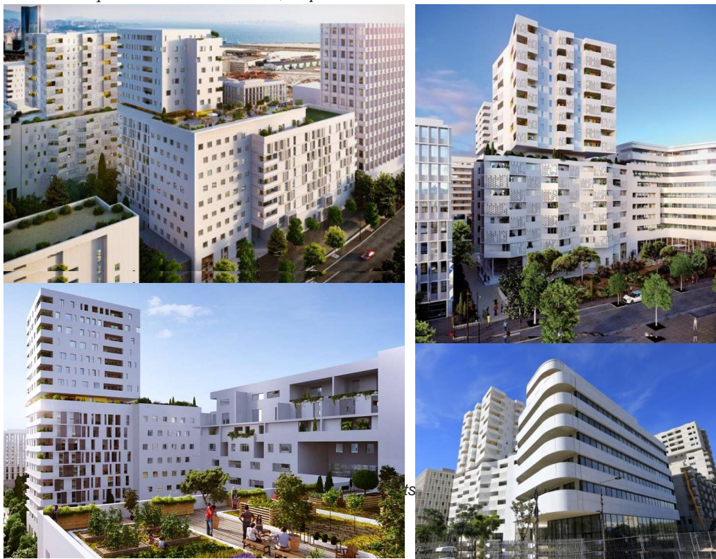
Figure 63 : L'éco-quartier de Smartseille, Aspect architectural
