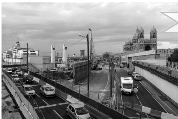
AVANT : Boulevard de la méditerranée avant la démolition du viaduc autoroutier.
