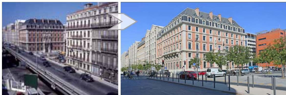
AVANT : Le viaduc de la joliette avant sa démolition.
