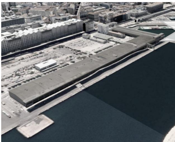
AVANT : Anciens hangars du port.
