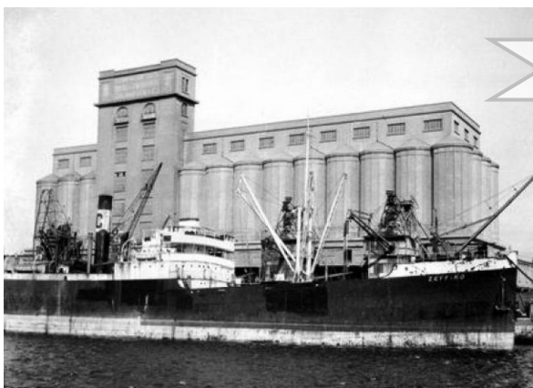
AVANT : Le Silo avant reconversion.
