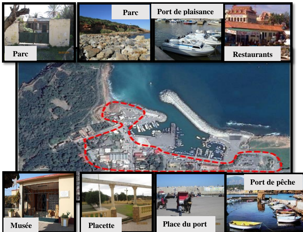
Figure 19 : Vue sur l'aménagement autour de l'aire d'intervention
