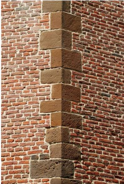
**fig 66** chaîne d'angle
