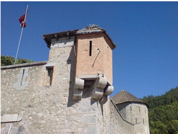
fig 63 Guérite en briques sur corbeaux, à Colmars (fort des Alpes).
