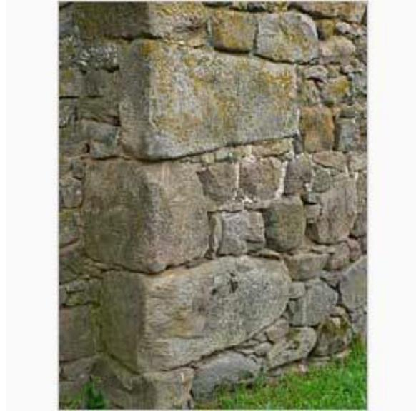
**fig 67** Chaîne d'angle
