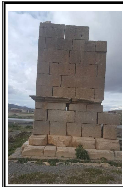
Fig 32 : façade sud(prise par l'auteur)
