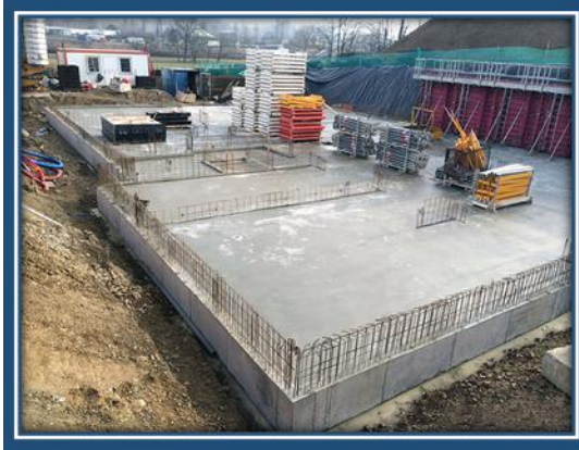
Figure 122 : les fondations en radie source google image
