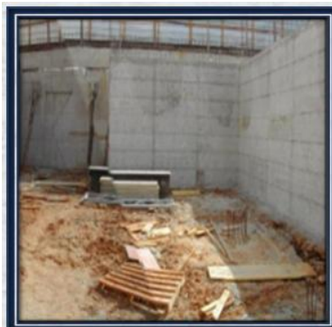
Figure 123 : voile en béton armé
