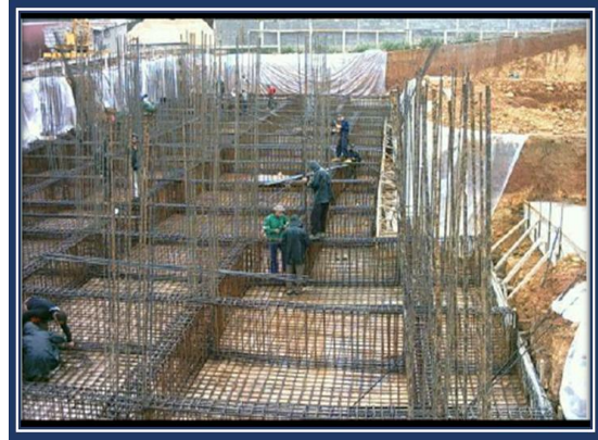
Figure 122 : les fondations en radie source google image
