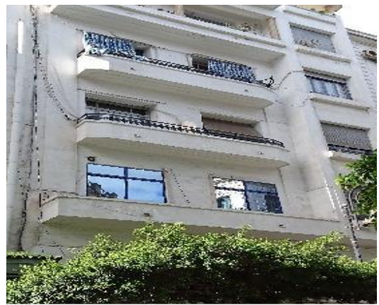
Figure 18: Façade de style art déco Alger. SAOUDI Siham 2017.
