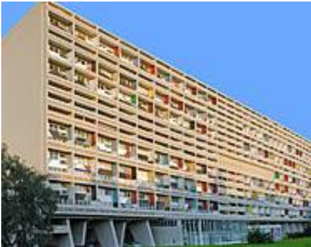
Figure 10:Façade du style moderne. Google image.
