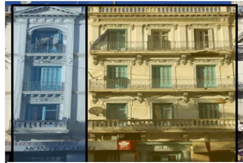
Figure 2: Façade asymétrique d'un bâtiment de la ville de Bejaia. SAOUDI Siham 2019.
