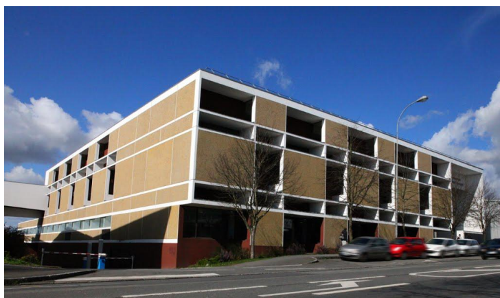
Figure 17 vue sur façade nord ouest
