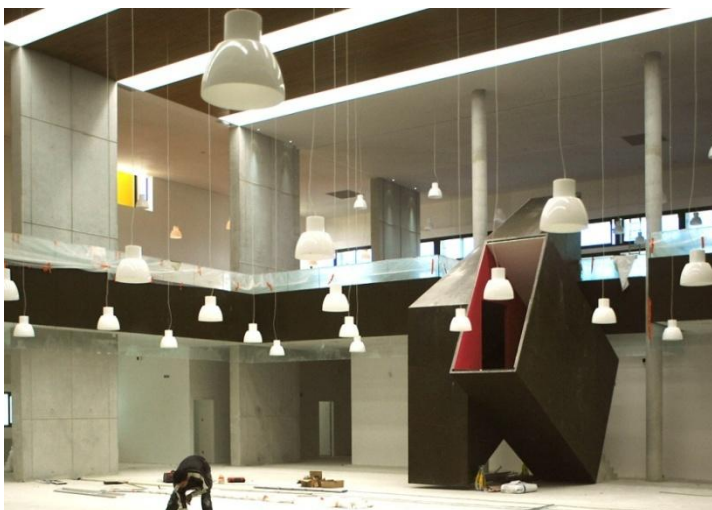
Figure 29 au cours de la finition
