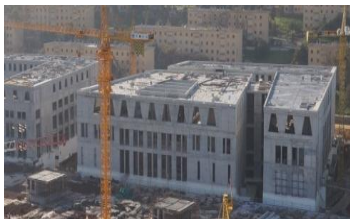
Figure 47 bibliothèque au cours de réalisation
