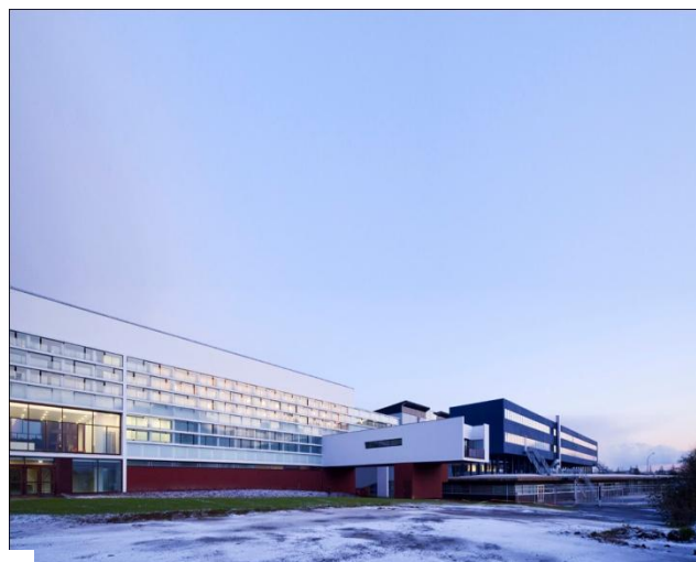
Figure 18 vue sur la façade sud est
