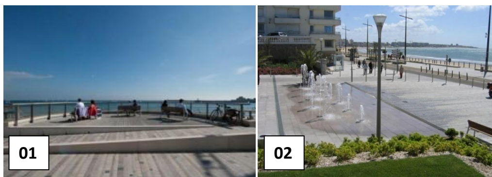
Figure 46: Rénovation de front de mer de Sables d'Olonne
