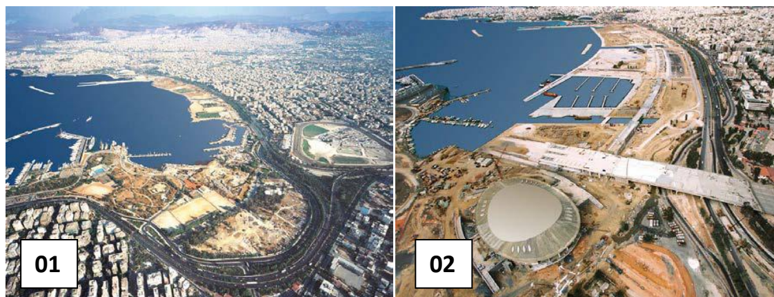
Figure 41 : Le front de mer de Faléron avant et après le projet d'aménagement
