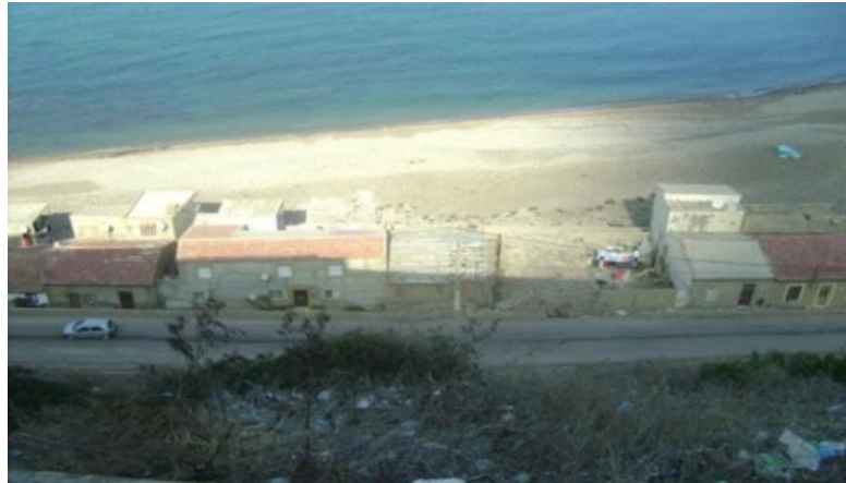
Figure 11: Vue sur les constructions illicite
