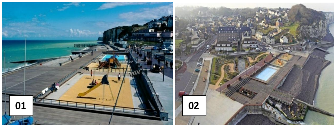
Figure 49: Rénovation de front de mer de Veules-Les-Roses
