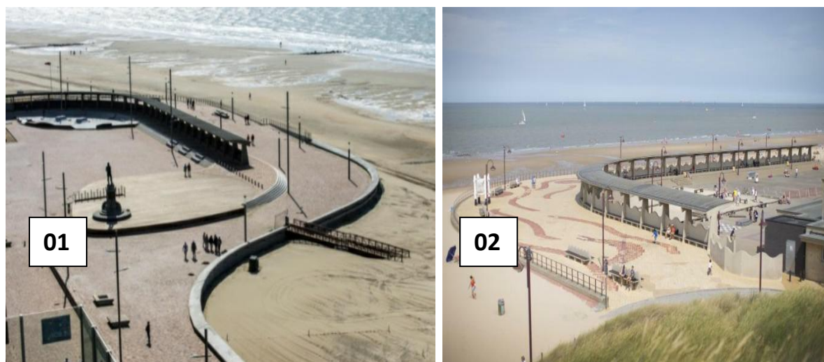
Figure 45: Rénovation de front de mer de Wenduine
