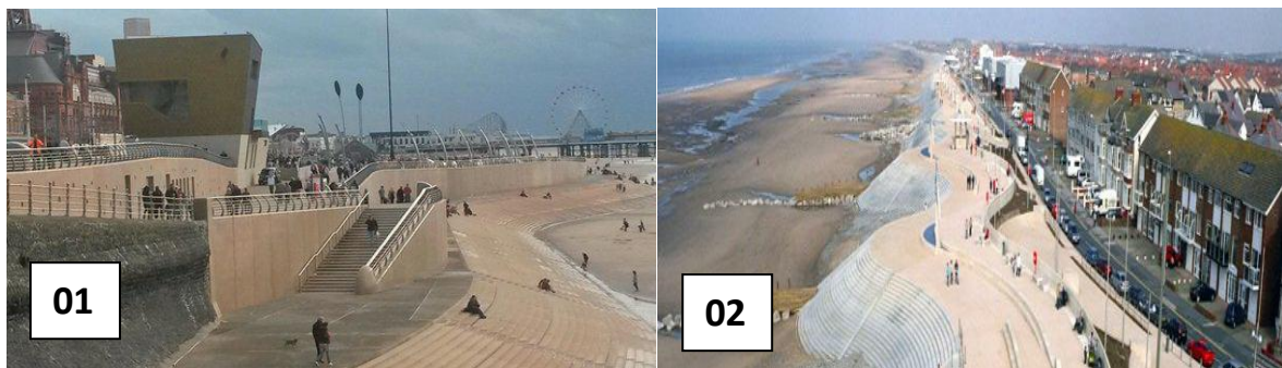
Figure 44: Rénovation de front de mer de Cleveleys
