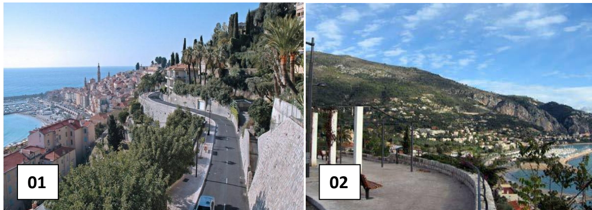
Figure 52: La requalification du boulevard panoramique de Garavan, à Menton
