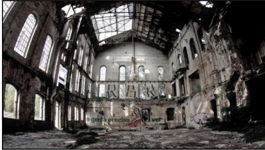
Figure 14 : usine de sucre ERIDANIA état de friche Source : http://www.heritagelupovicien.fr/lancienne-sucrerie/
