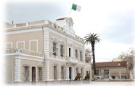
Figure 47: La mairie de Boufarik SOURCE : Auteurs
