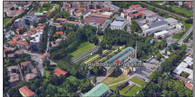
Figure 9 : vue aérienne de la situation de Auditorium PAGANINI
