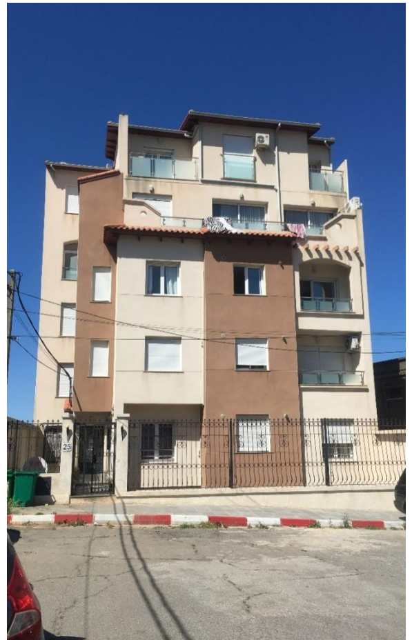
Figure 108 : Vue sur façade principale
