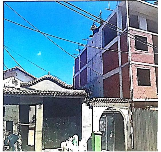
Figure 95 : Reconstruction , Travaux en cours
