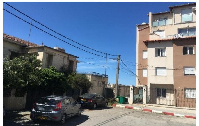
Figure 100 : Vue sur façade principale
