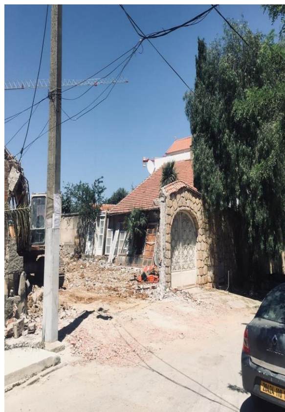
Figure 70 : Vue sur accès à la parcelle en chantier (travaux de démolition en cours)
