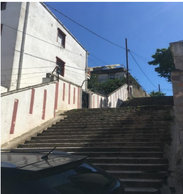
Figure 109 : Vue sur escalier extérieur
