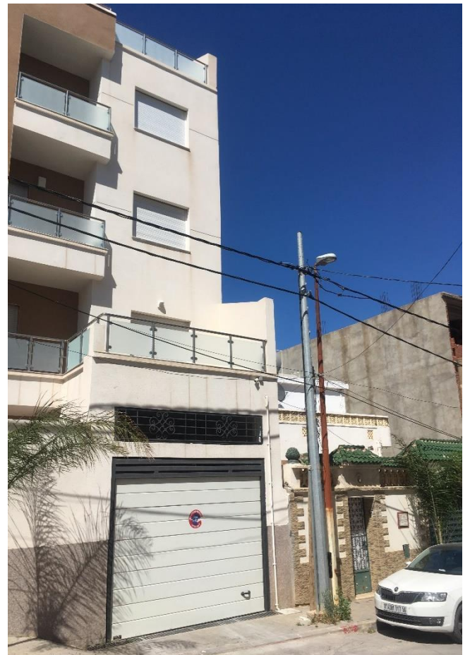
Figure 93 : Vue sur accès au parking en sous sol
