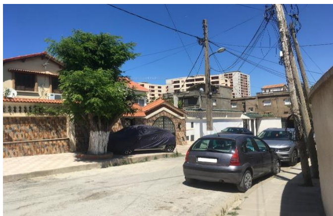
Figure 73 : Vue sur rue de desserte donnant sur chantier de démolition en cours
