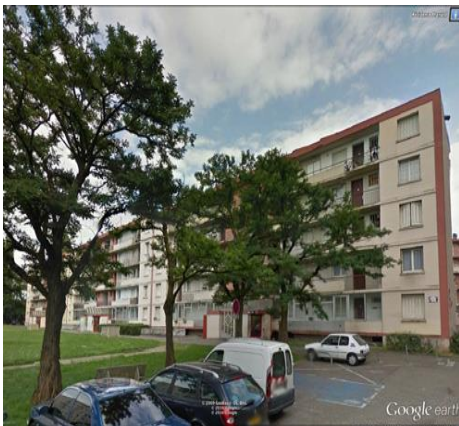
Figure N°26 : Résidence Prnard avant - EMH- Villeurbanne
