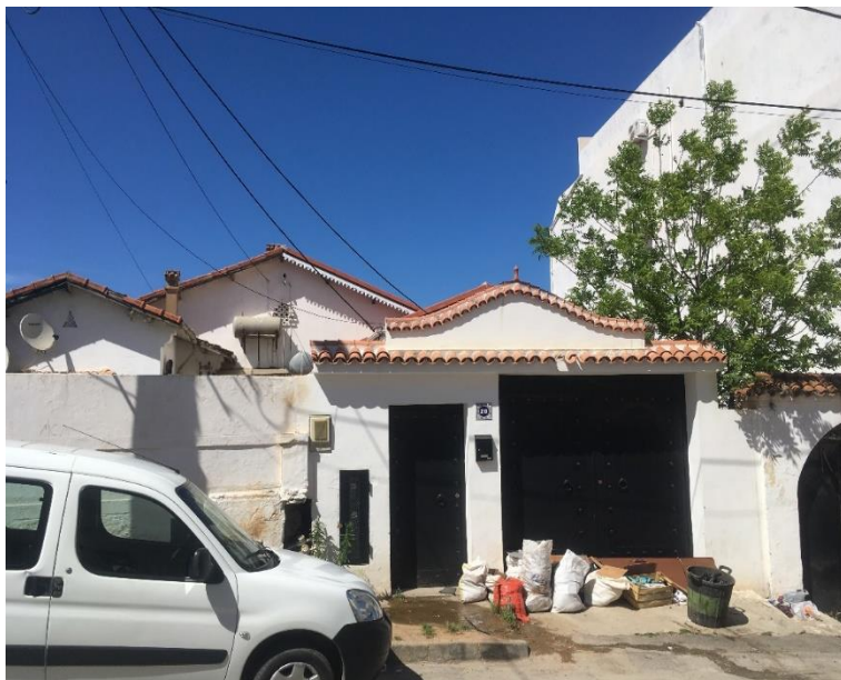
Figure 96 : Vue sur façade principale
