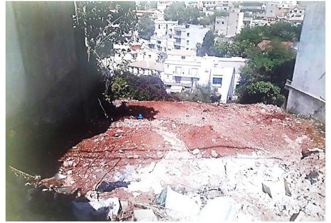
Figure 91 : Ouverture de chantier, Travaux de démolition
