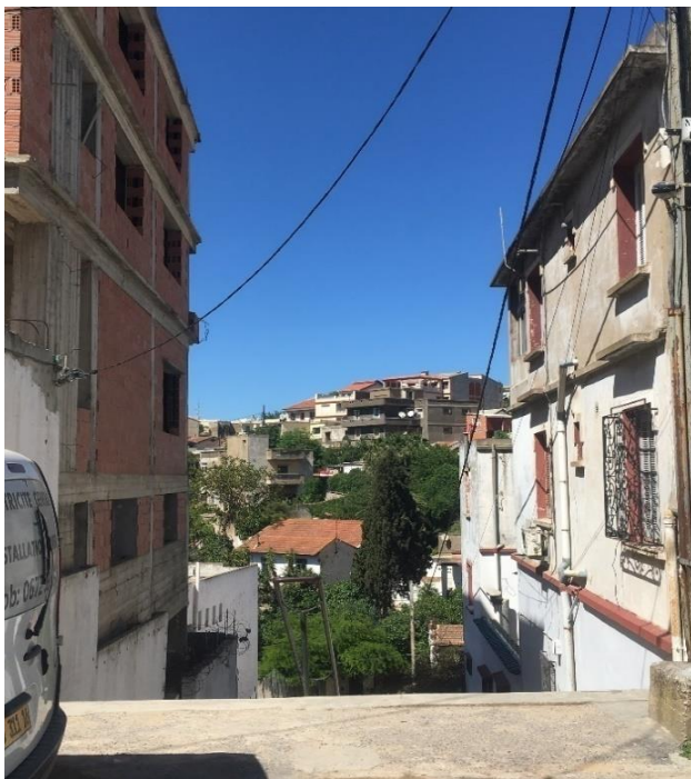
Figure 101 : Vue sur escalier extérieur de desserte
