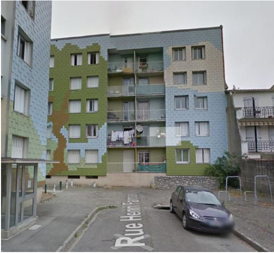
Figure N°14 : accès au parc en retrait
