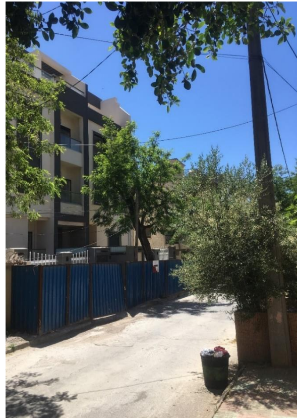
Figure 59 : Vue sur façade principale
