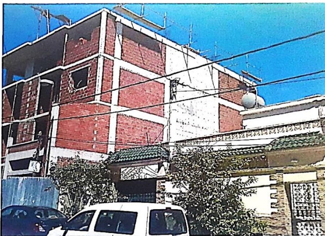
Figure 92 : Reconstruction , Travaux en cours
