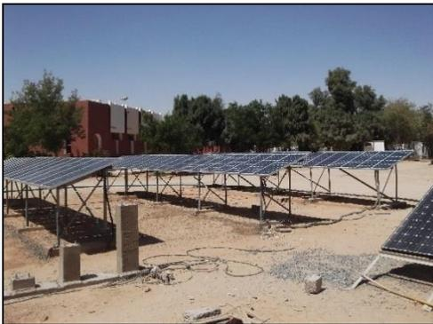
Figure 66 L'installation des panneaux sur une structure métallique surélever au sol
