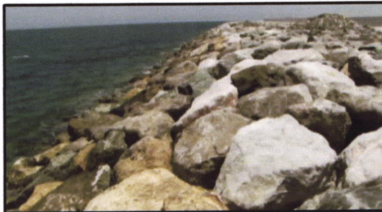
Illustration 5.9 : réalisation de la digue de protection
