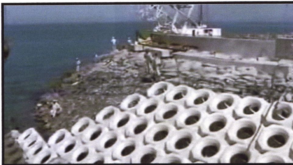
Illustration 5.10: Vue sur une digue de protection
