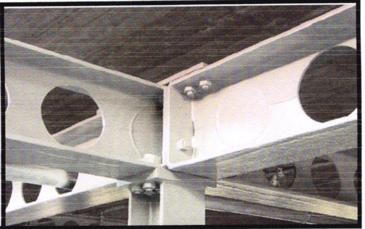
Fig.N°116 : assemblage poutre -poutre
