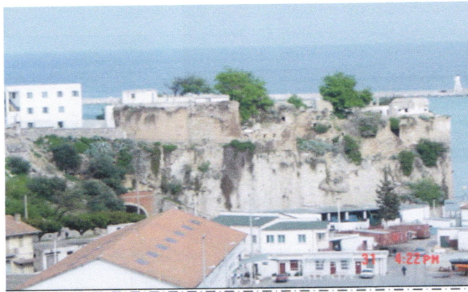
Photo 30: vue sur le fort AEK et les hangars autours
