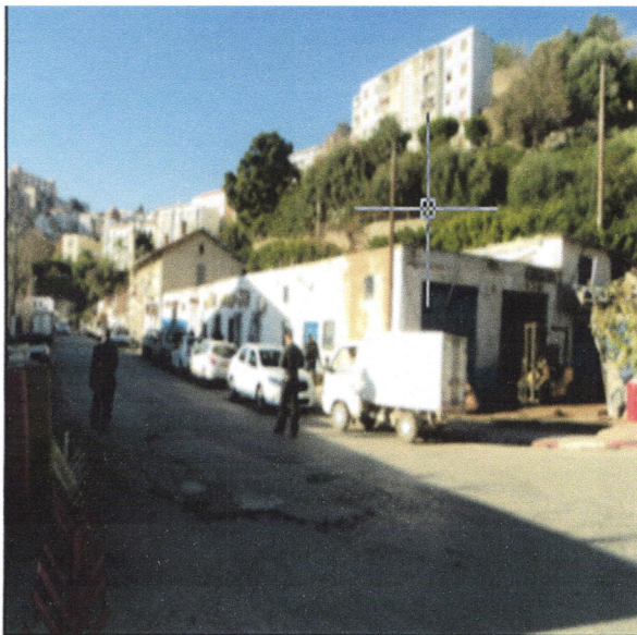
Photo : à partir de l'extérieur de la ville
