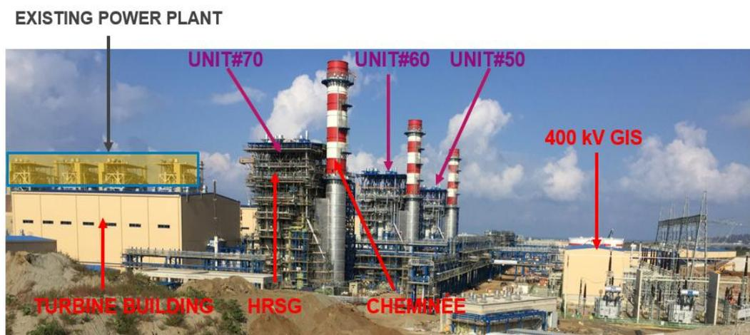
Figure 2-3 : Image présentable des cheminées et HRSG et le département de la turbine
