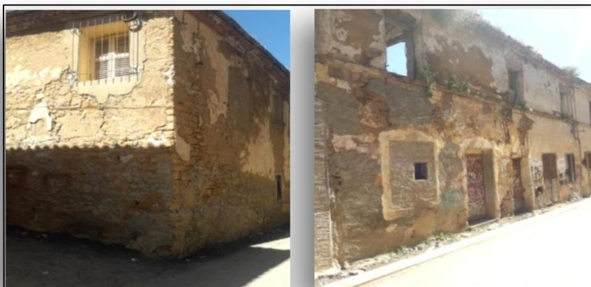
**Photo 08 : Dégradation avancée**
