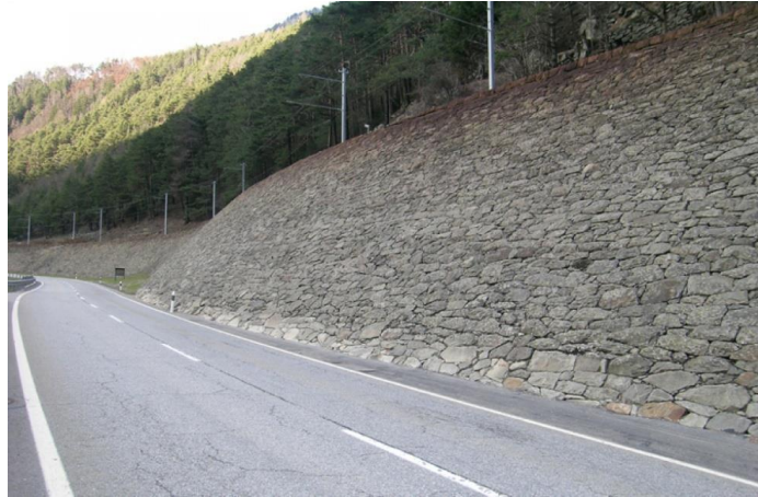
Figure I.8. Mur en maçonnerie de pierres sèches
