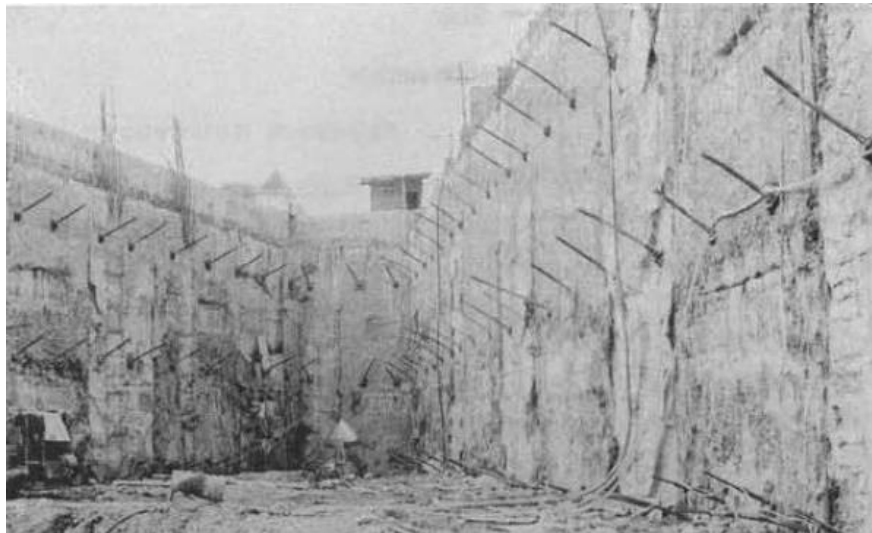
Figure I.6. Photo de la méthode d'excavation ancrée (1)
