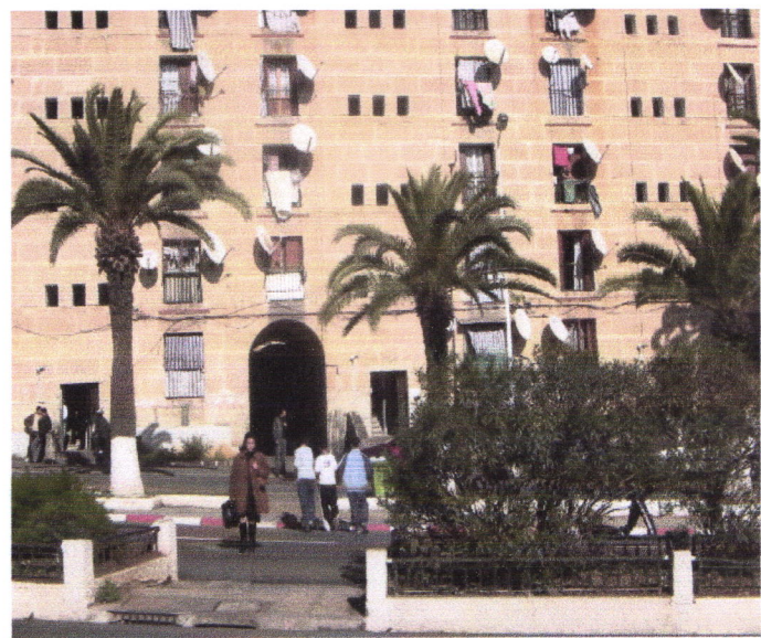
Fig.3.27 : Façades extérieures (contact avec l'environnement immédiat).
