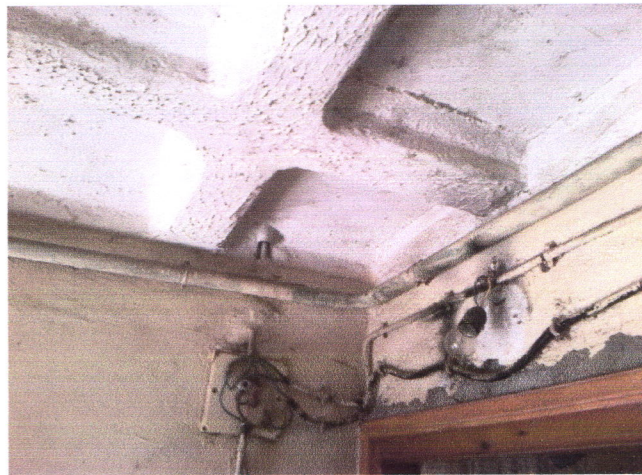
Fig.3.31 : Plancher à caissons
