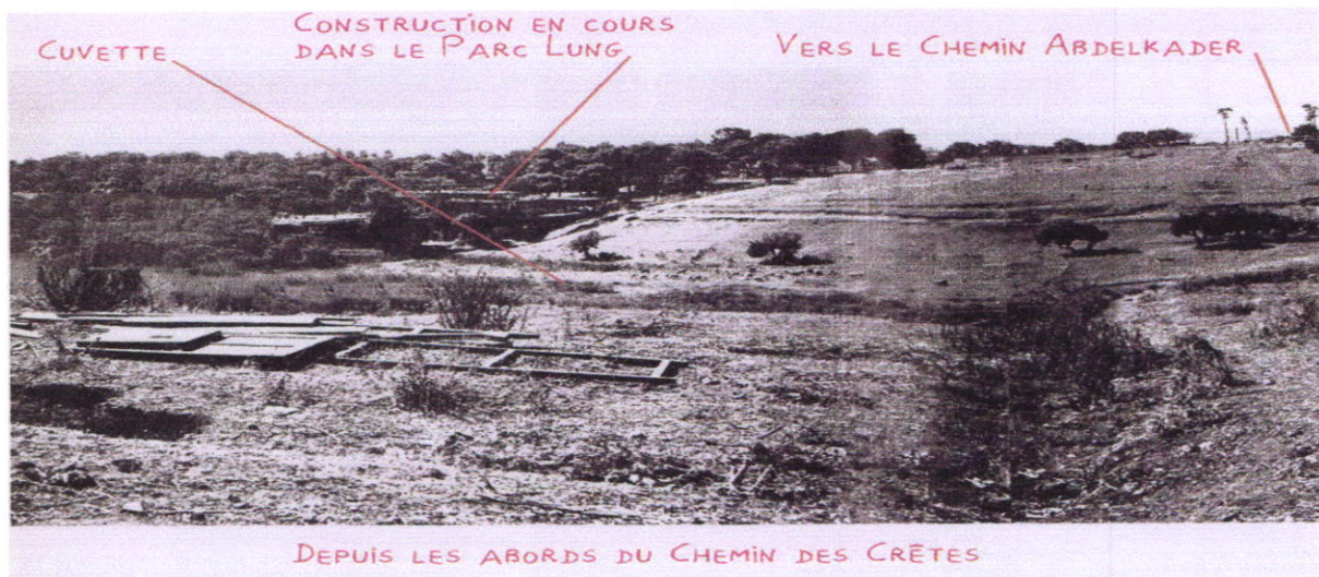
Fig.2.15 : Vue sur le terrain avant le projet (terrain vierge).
