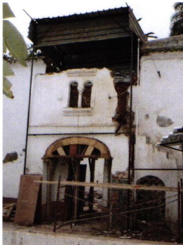
Restauration par anastylose (remontage des pièces démontées)
