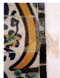
Image 60 Consolidation par restitution partielle des parties manquantes. L'autre par la continuité de l'image.
