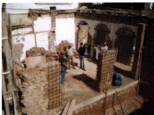
Image 83 Démontage des planchers pourris et chemisage des parties de structures.
