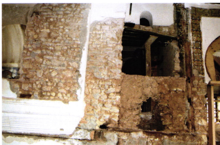
Image 66 Travaux de dérestauration des réseaux d'évacuation des eaux pluviales.
