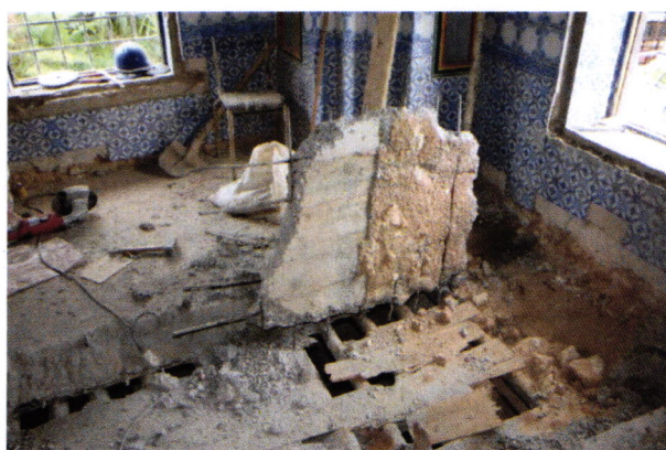
Image 68 Dérestauration des dalles de béton, du plancher de la favorite.
