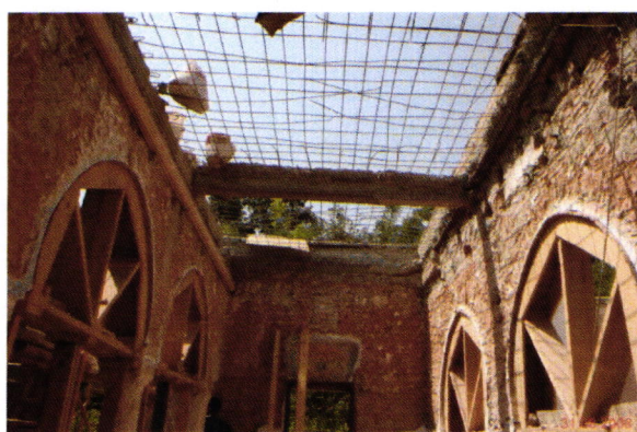
Image 67 Dérestauration des dalles de béton, du plancher
