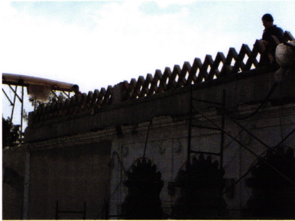
Image 72 Eléments de la façade restaurés.
