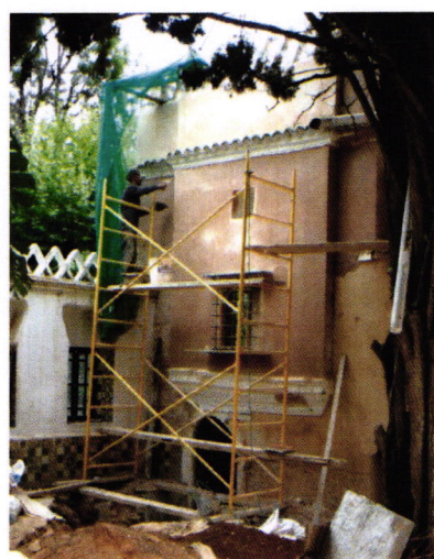
Image 65 Restitution par anastylose des parties endommagées.
