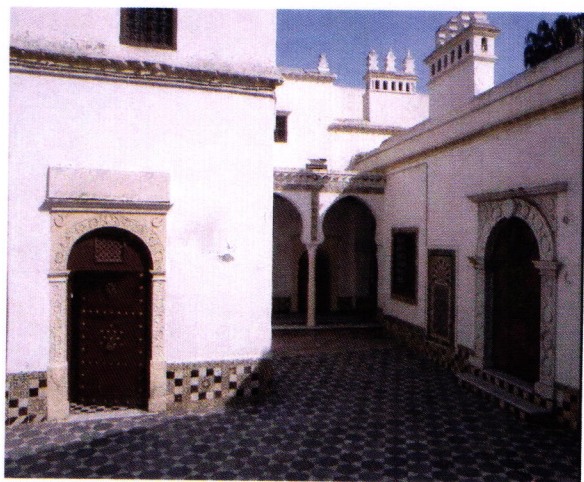
Image 50 Les divers accès de la cour supérieure.
