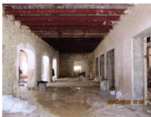
Image 82 Pose d'un nouveau plancher métallique compatible avec l'ancien plancher.
