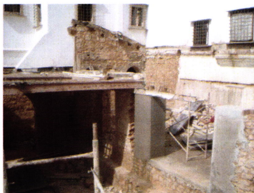
Image 83 Démontage des planchers pourris et chemisage des parties de structures.
