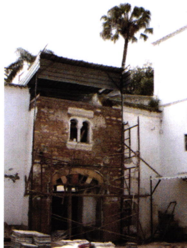
Restauration par anastylose (remontage des pièces démontées)
