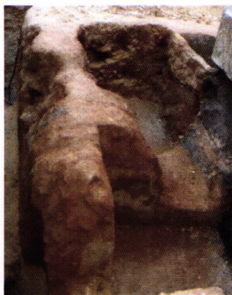
Image 19. Anciennes parties démolies pour le déplacement des espaces et l'agrandissement du patio.
