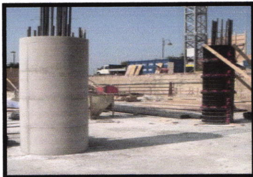
Figure N=63 :Poteaux circulaire en béton armé
