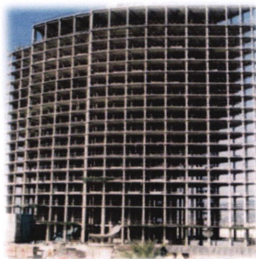
Figure III-11 : Structure de l'hôtel Sheraton d'Oran. Source : www.oran-dz.com .
