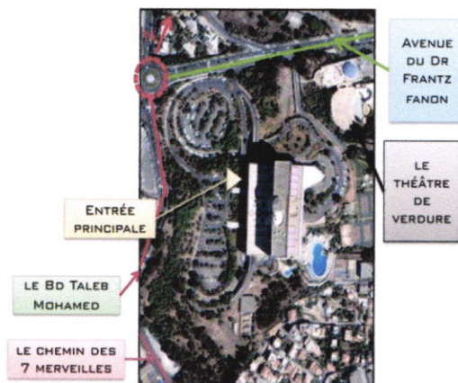
Figure III-14 : Situation de l'hôtel AURASSI. Source : www.el-aurassi.com , Traité par les auteurs.
