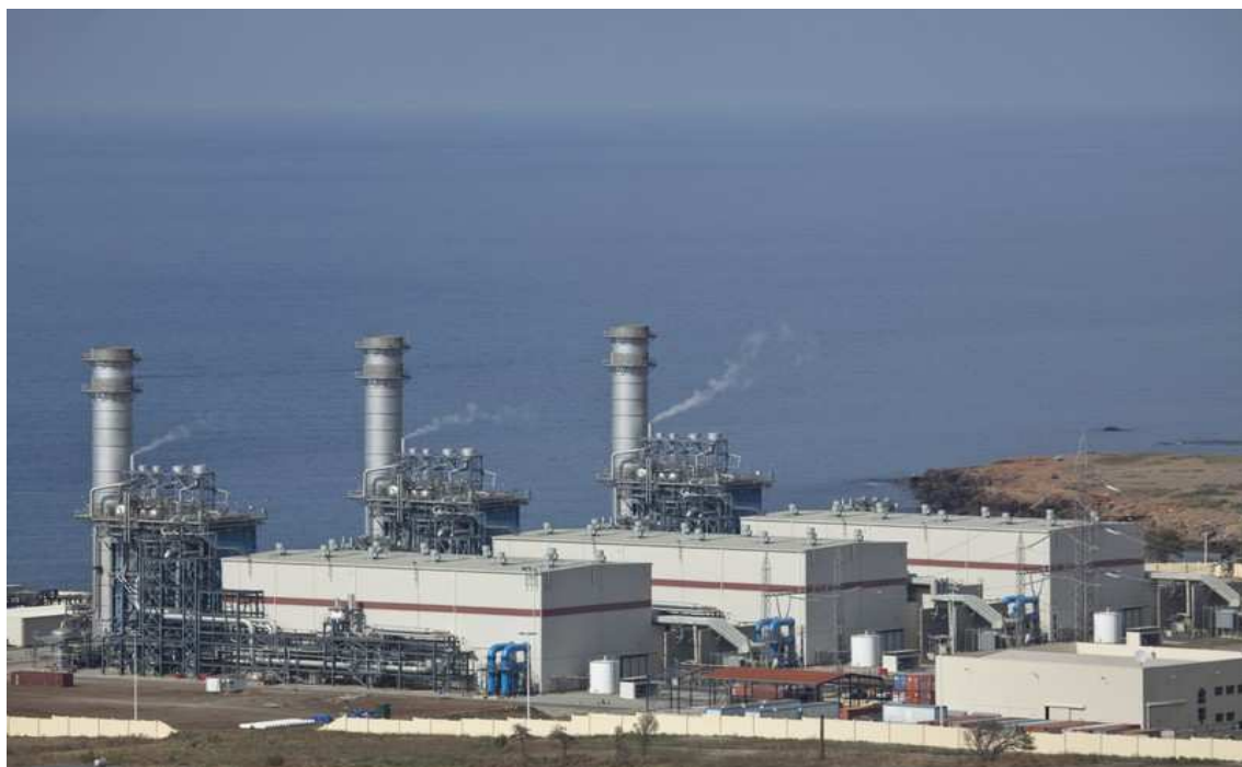
Figure 2.3. La centrale thermique 1227 MW de HAJRET EN NOUSS.
