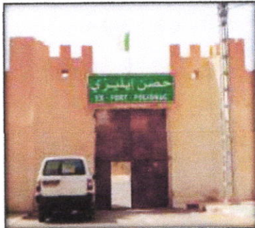
Figure n°66 : Porte principale en acier.
