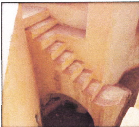
Figure n°74 : escalier vers les remparts
