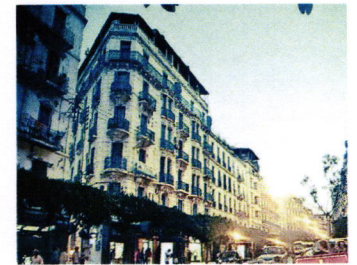
Façade d'un immeuble de l'époque coloniale civile (1)
