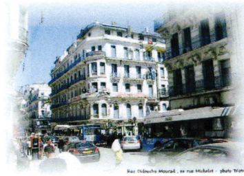
Façade d'un immeuble à la rue Didouche Mourad, Alger (1)
