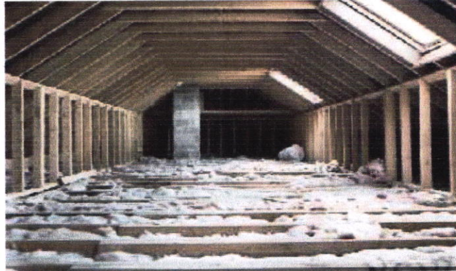
Figure 1: Image représentant l' application de l'isolation la toiture
