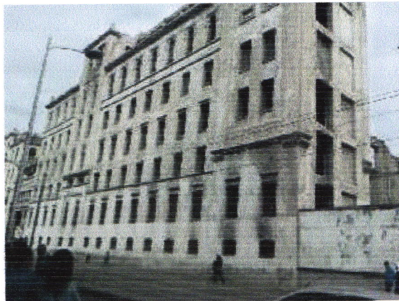
Figure 29: photographie prise de la façade principale de la minoterie Narbonne
