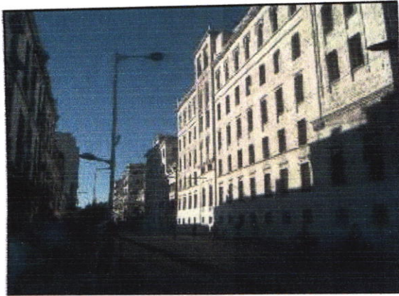
Figure 5: la minoterie Narbonne, friche industrielle en plein milieu urbain (notre cas d'étude), Hussein Dey, Alger Source Auteur le 27-06-2017
