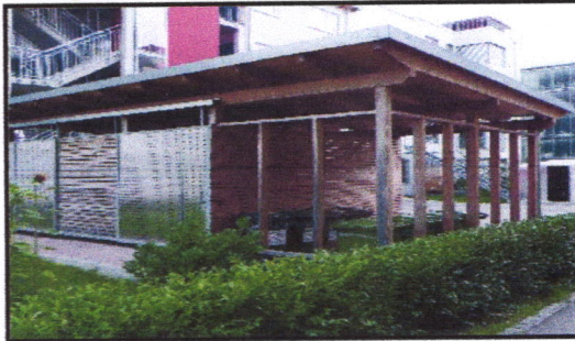
Figure18 : Abri vélos et poubelles. Vauban, Fribourg (All.).
