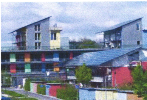
Figure4 :Le quartier Vauban de Fribourg-en Allemagne Source : exposé étudiant
