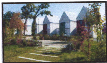
Figure14 : Placette en coeur de quartier, Vern-sur-Seiche (35).
