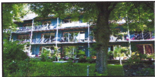
Figure 13: façade sud, Bâtiment passif : conception bioclimatique. Quartier Vauban, Fribourg (All.)
