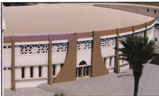
Figure 104 : vue sur le restaurant ; source : auteurs 2018.
