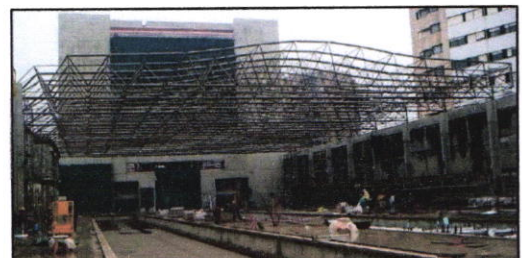
Figure 132 : vue le chantier de réalisation ; source : http://www.archistructur.org
