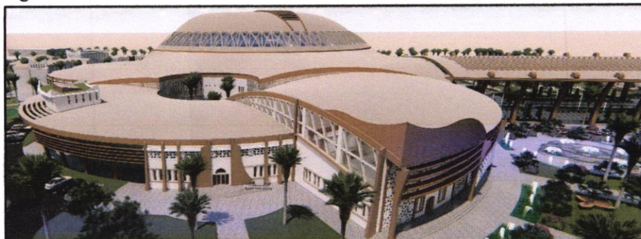
Figure 99 : vue sur l'ensemble du projet ; source auteurs 2018.
