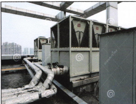
Figure 161 : Unité extérieure de climatisation centrale : principe de fonctionnement d'une installation de climatisation centrale ; source : https://fr.dreamstime.com/unit%C3%A9-ext%C3%A9rieure-de-climatisation-centrale-
