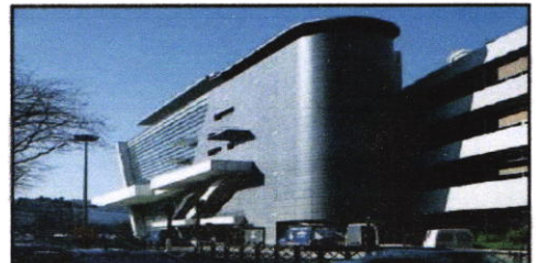
Figure 25 : vue sur la façade du palais des congrès de paris ; source https://fr.wikipedia.org/wiki/Palais_des_congr%C3%A8s_de_Paris .
