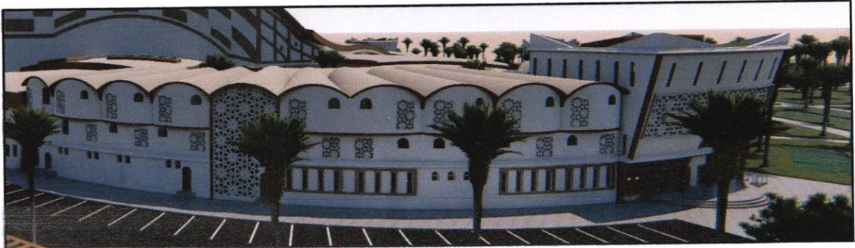
Figure 106 : vue sur les suites ; source : auteur 2018.
