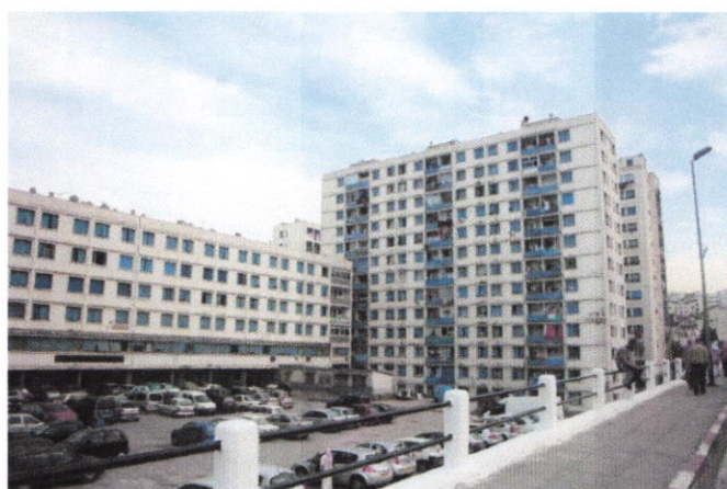
Figure 47 : Illustration sur une des cités de logement collectif HLM a Bab el oued
