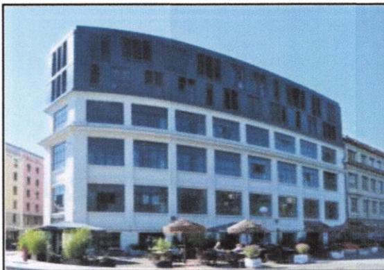
Figure 9 : Les bâtiments industriels après la rénovation
