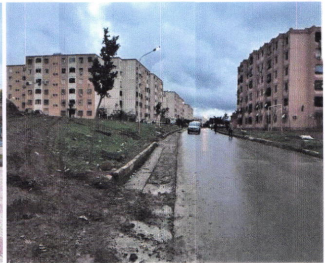
Figure 9 : La cité 1000 logements à Ouled Yaich Blida, la distribution éparpillée des barres de logements qui se ressemblent entre elles.
