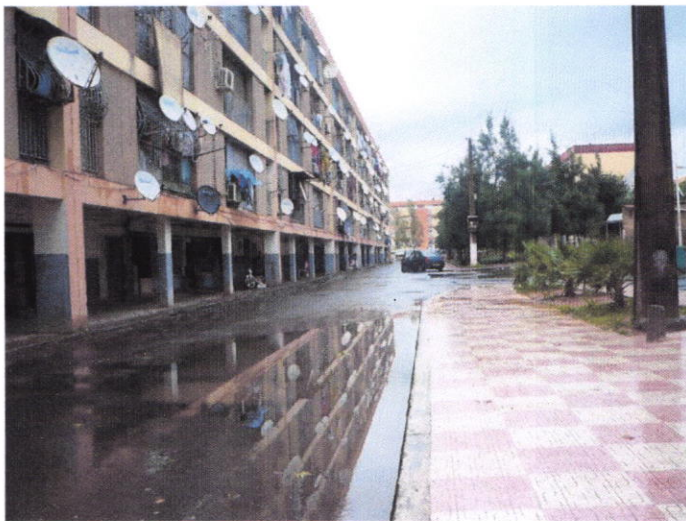
Figure 8 : La cité des Banani de Blida, une cité dortoir où les services sont absents et le cadre de vie n'existe même pas vu son état dégradé
