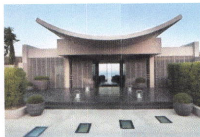
Figure 76 : Illustration d'un seuil d'une entrée principal
