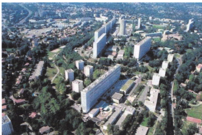
Figure 63 : Illustration sur une avant rénovation urbaine au quartier de la Duchère – France
