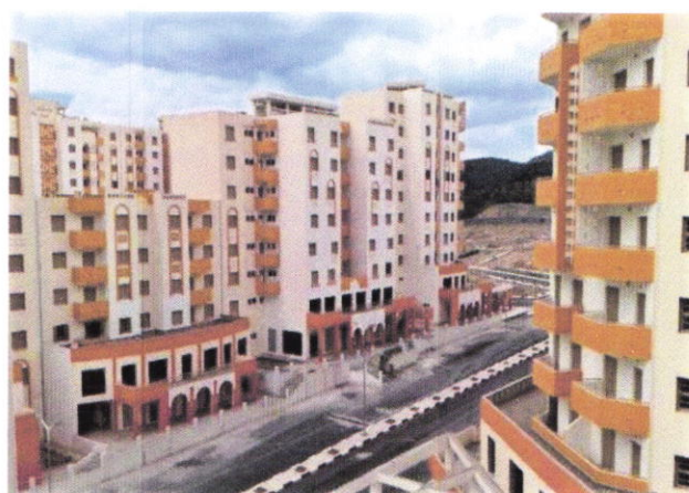
Figure 46 : Illustration sur une des cités de logement collectif AADL de Kolea
