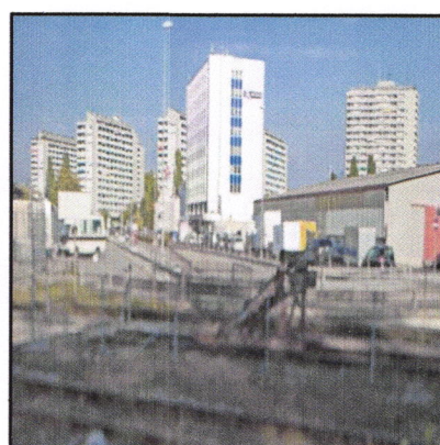
Figure 6 : La standardisation et l'absence de mixité fonctionnelle dans les quartiers
