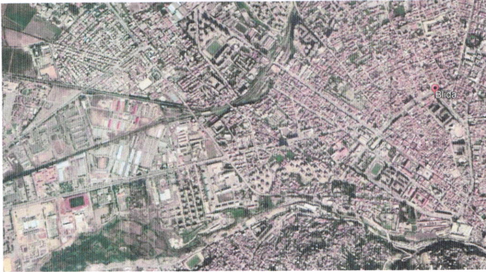
Figure 18 : Photo aérienne globale sur la ville de Blida, la différence entre le tissu ancien et la périphérie de la ville Source : Google Maps
