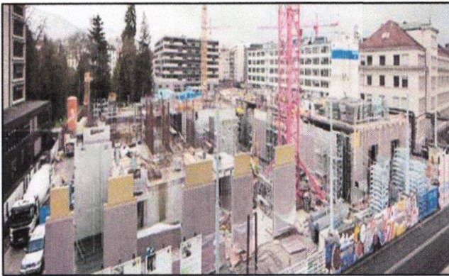
Figure 7 : Un quartier de périmètre « Jordan » en chantier
