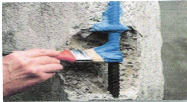
**Figure 8** : Utilisation de peinture hydrofuge contre la corrosion.
