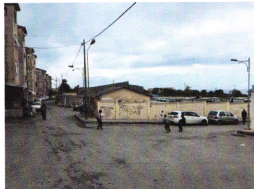
Figure3.19: Photo du site Source par les auteurs
