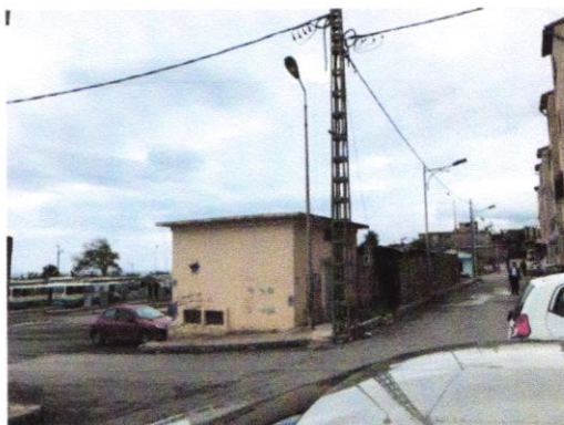
Figure3.18: Photo du site Source par les auteurs
