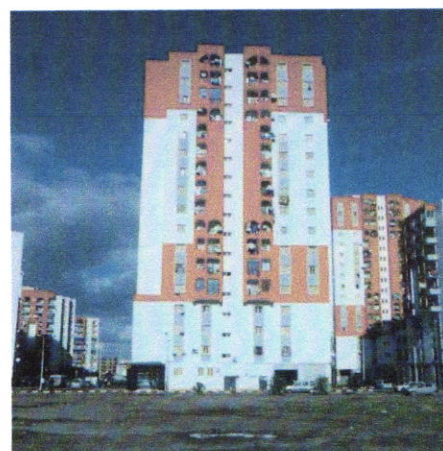
Figure : 1.6 Construction anarchique Source : Par les auteurs
