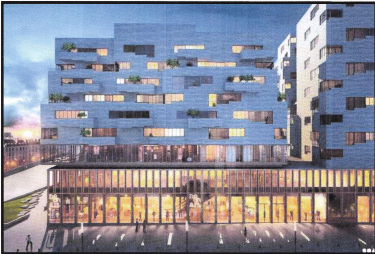
Figure 19 : façade du tour d'habitation
