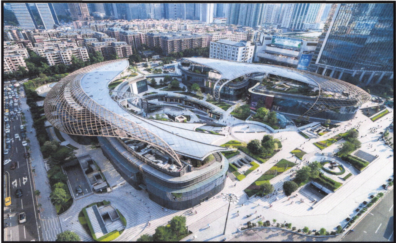
Figure 15 : photo perspective du centre commercial PARC CENTRAL
