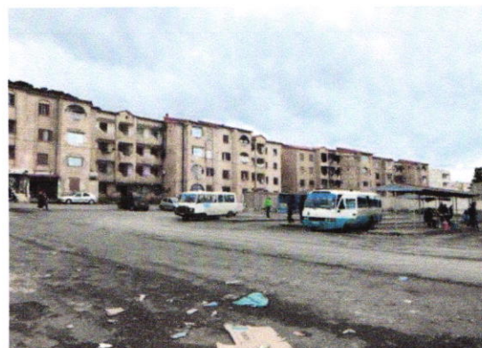
Figure3.17: Photo du site Source par les auteurs
