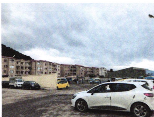
Figure3.16: Photo du site Source par les auteurs
