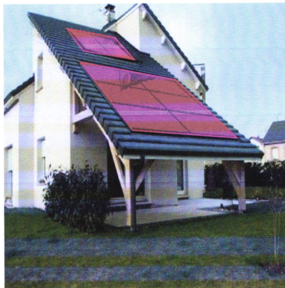
Figure: panneau solaire intégré à la maison
